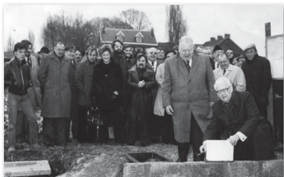
Pose de la première pierre du mille-club de Douai, par le maire de la ville, en 1974.
