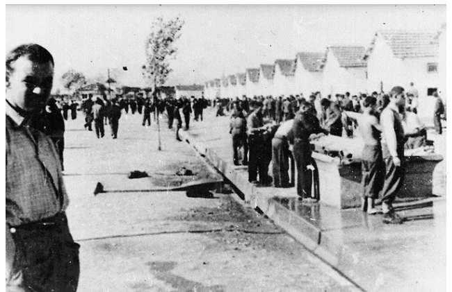
Camp de Miranda de Oro, le lavoir et l'allée principale. Photographie non datée
