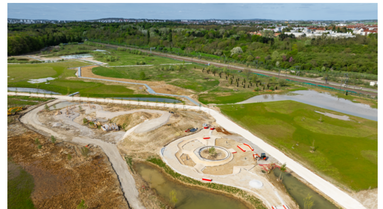
Terrain des Essences en travaux
