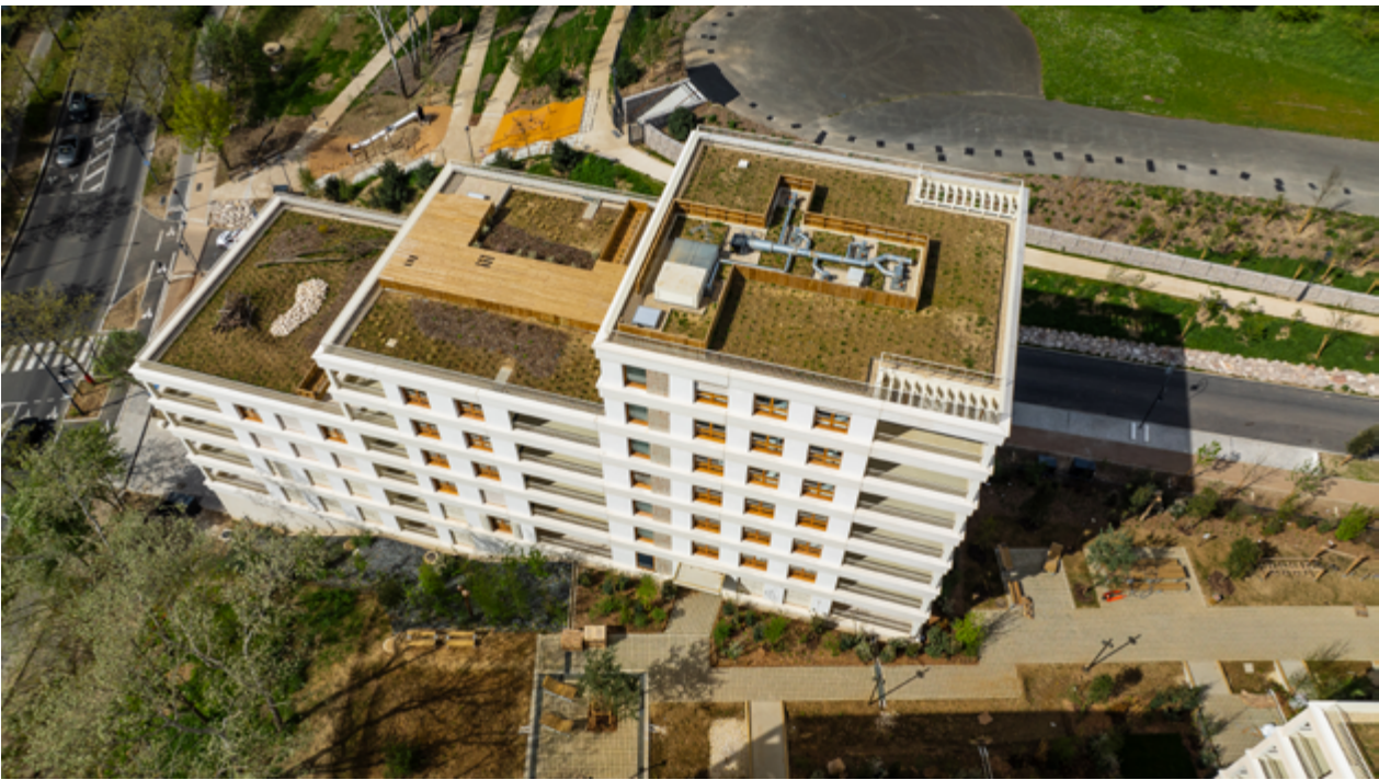
Refuges pour la biodiversité en toiture sur le secteur de l’Aire des Vents
