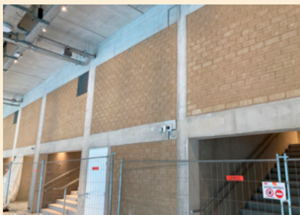
Murs en brique de terre crue dans le hall de l'Arena Porte de la Chapelle
