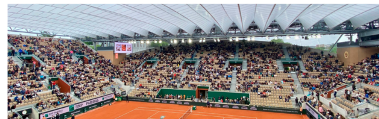
Couverture du court Suzanne Lenglen
