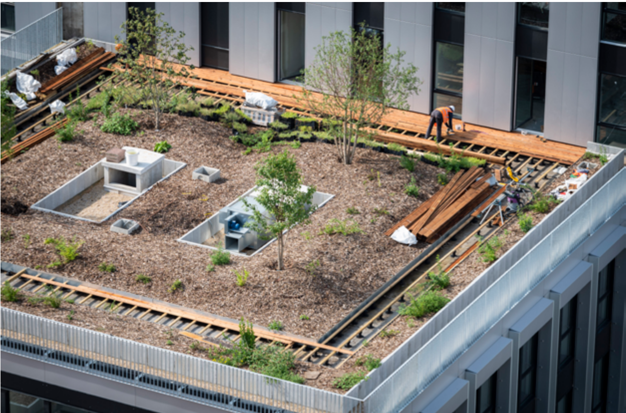
Toiture végétalisée du Village des Athlètes
