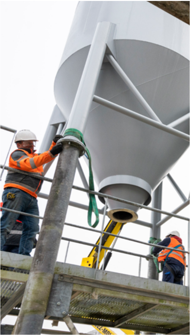
Une des centrales à béton sur chantier
