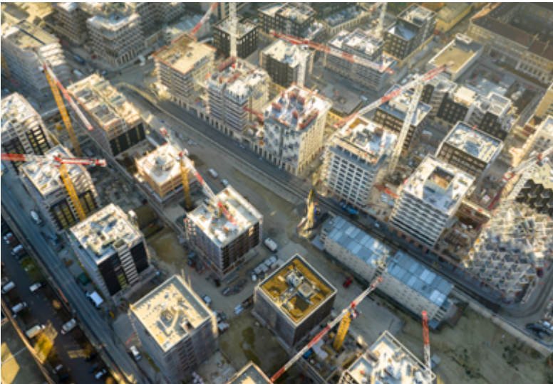
Vue aérienne des chantiers sur les secteurs Quinconces et Belvédères en décembre 2022
