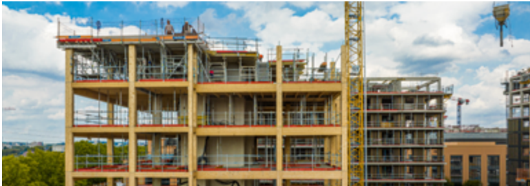
Vue en coupe de la construction d'un bâtiment en structure bois sur le VOP
