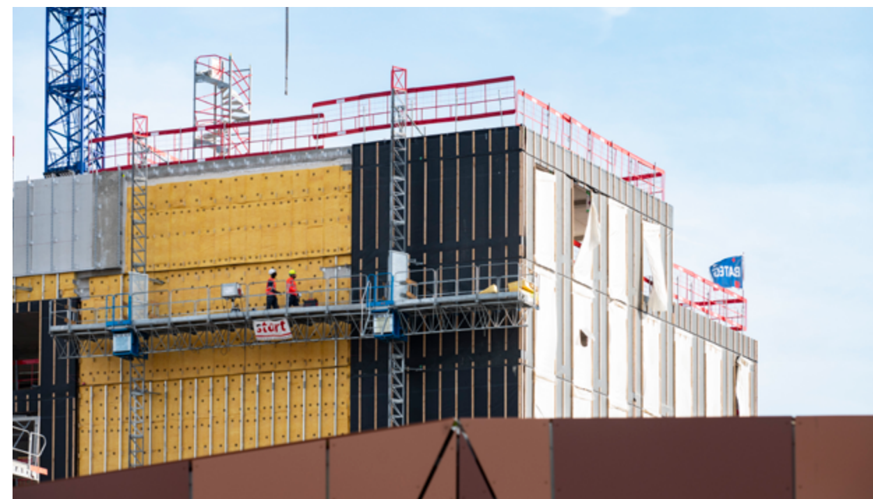
Mise en œuvre de l'isolation des façades du VOP
