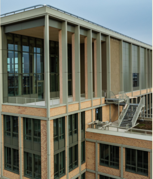
Le bâtiment de bureaux E3 du VOP
