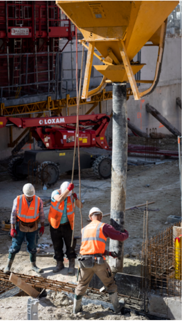
Coulage de béton
