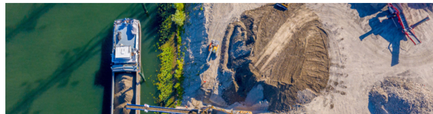
Transport fluvial des déblais
