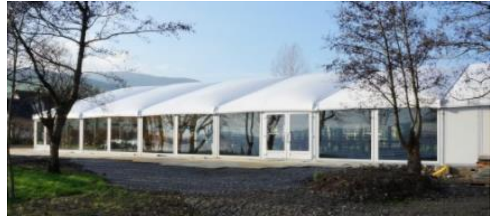
Isolation. Exemple Toit Thermo + Panneaux sandwich 40mm
