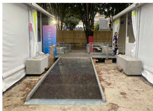
Exemples de différentes rampes et escaliers standards (métallique, plancher K7, échafaudage; avec garde-corps, avec chasse-roues) réalisés pour accéder à des tentes ou bungalows, parfois mutualisés pour plusieurs espaces, diverses structures.
