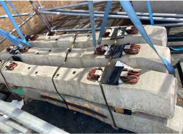
Lestage Réemploi Traverses SNCF
