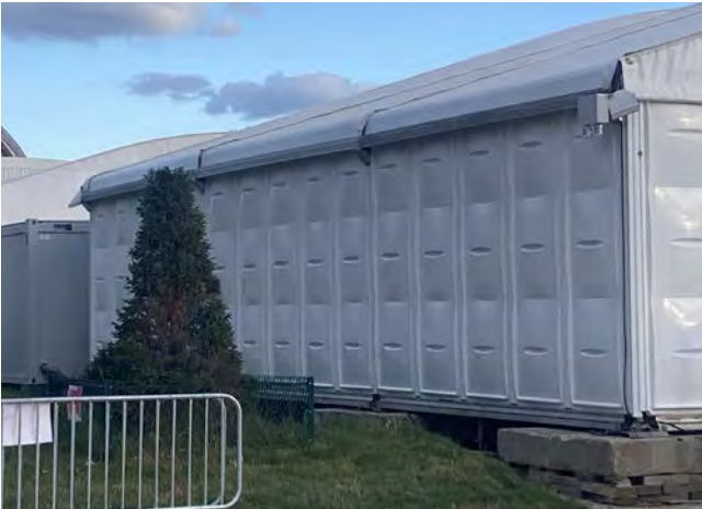
Lestage sous plancher
