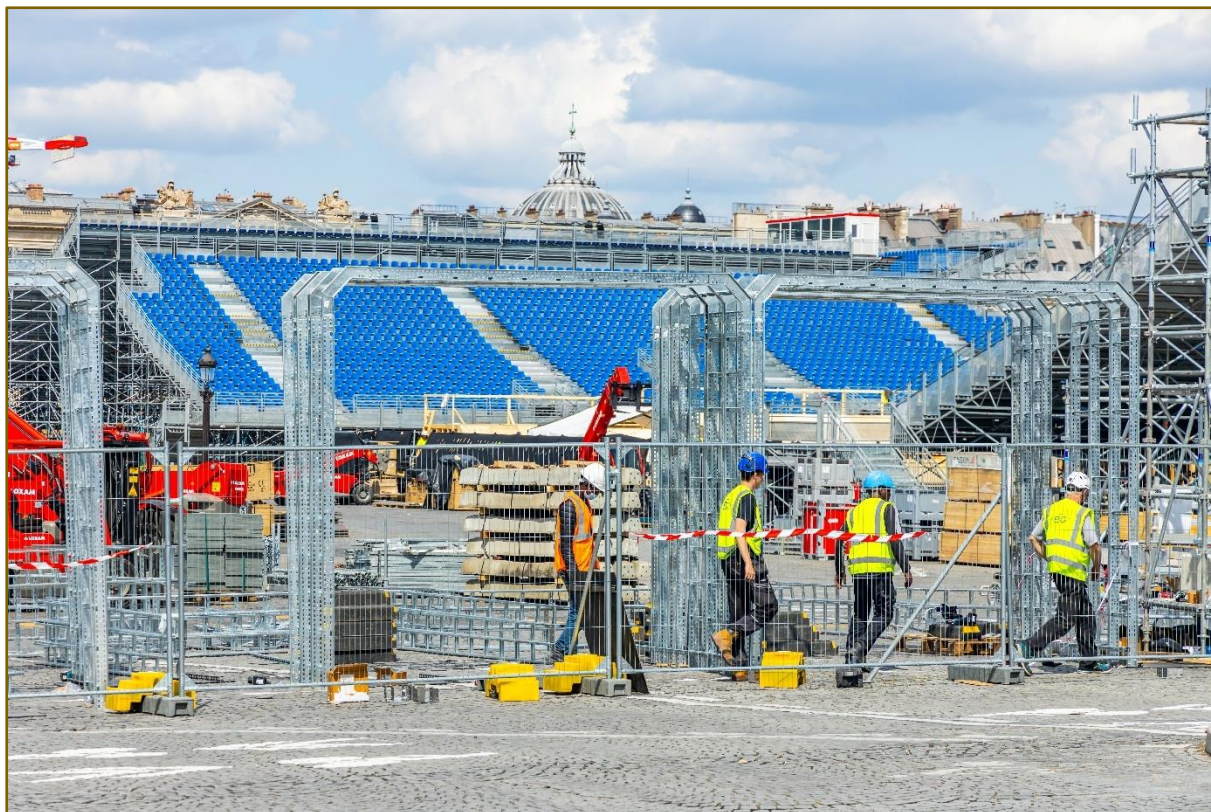
Le site de compétition de la Place de la Concorde en cours d'installation
