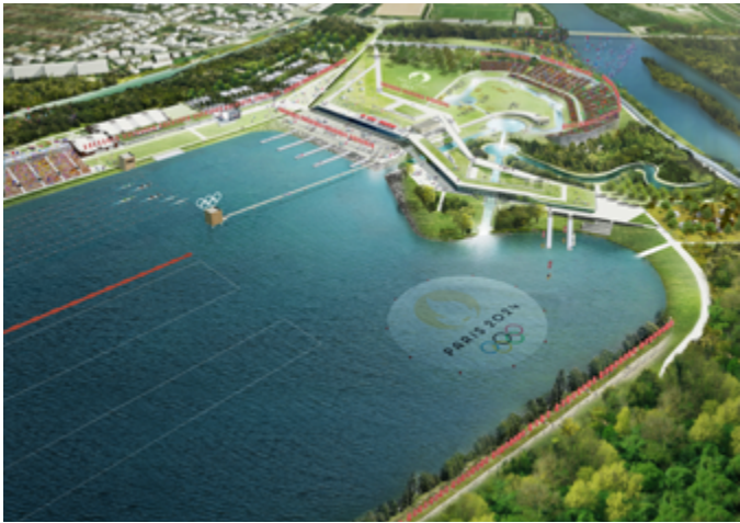
Exemple de site de catégorie A : Site stade Nautique Olympique de Vaires-sur-Marne
